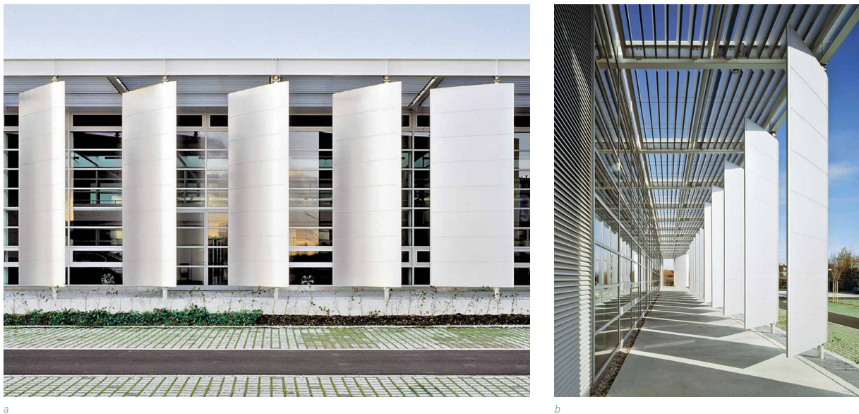
FIG. 10 a) Front view and b) corridor view of the adaptive façade of the Training Academy in Unterschleißheim ( Schulungsgebäude in Unterschleißheim, 2018 )
